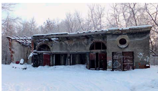
Иллюстрация 6. Комплекс жилых домов, гараж. Екатеринбург, Верх-Исетский бульвар, 18. Фото: Ю. Ю. Курашов. Нет собственника, не используется более 20 лет, состояние аварийное (стоит на насыпном грунте)
