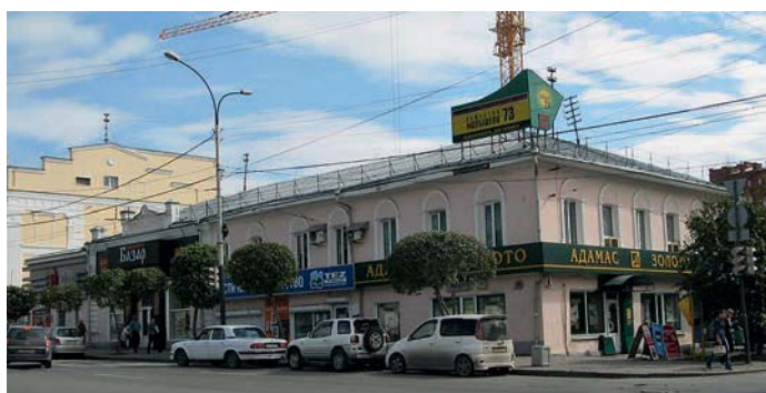
Иллюстрация 4. Магазин Блохиной. Комплекс. Екатеринбург, ул. Малышева, 64. Фото: Ю. Ю. Курашов. Состоит из трех разновременных зданий, интерьеры в значительной степени изменены. Используется под нежилые цели. Требуется реконструкция
